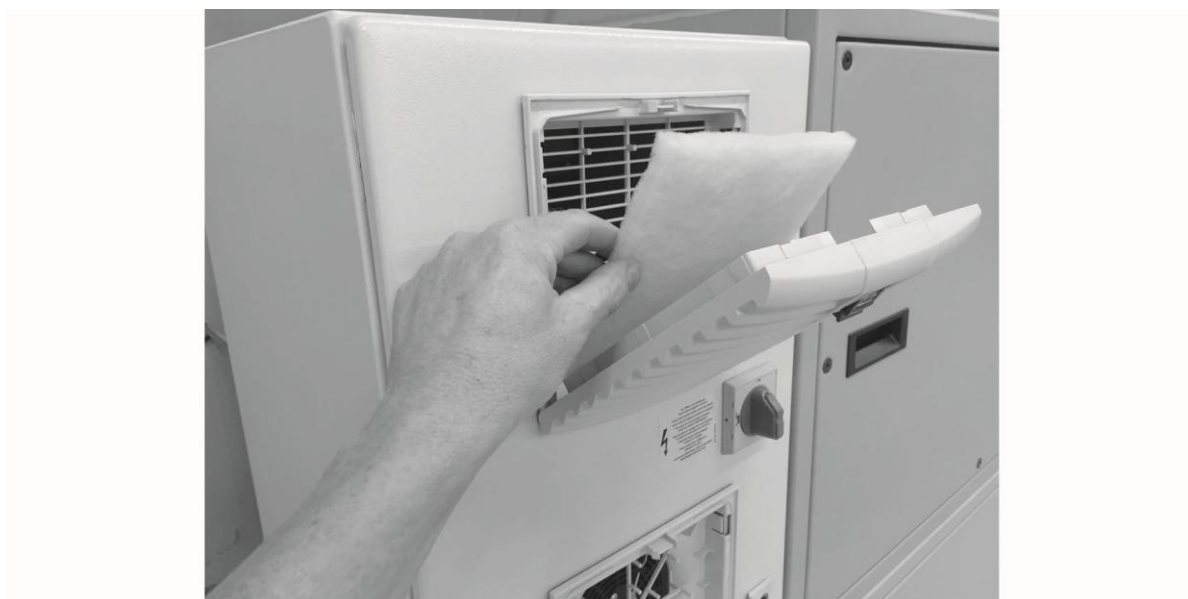
Fig. 57: Substituição do filtro no armário de distribuição
